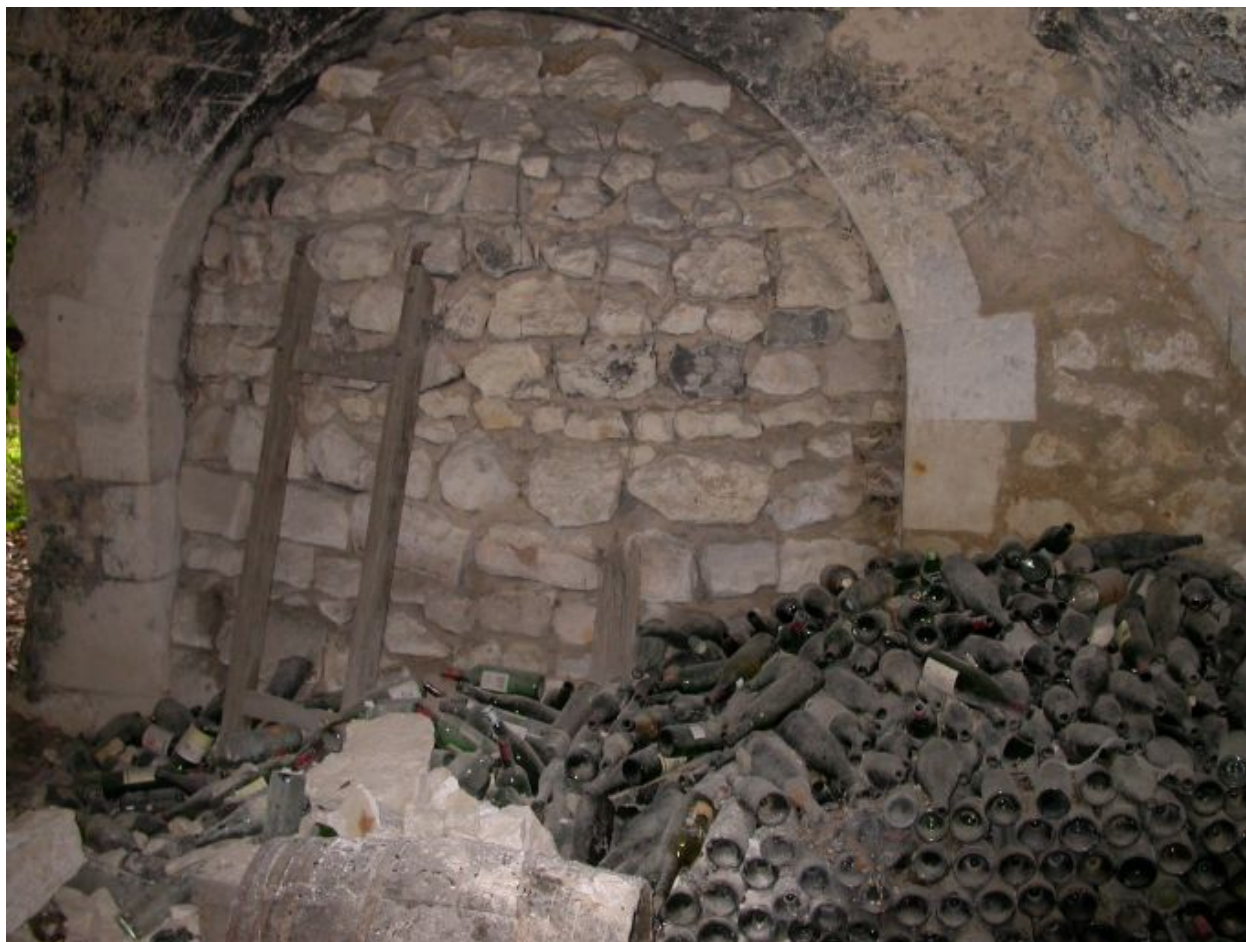
Abri troglodytique face à la maison : accès abstrué.
