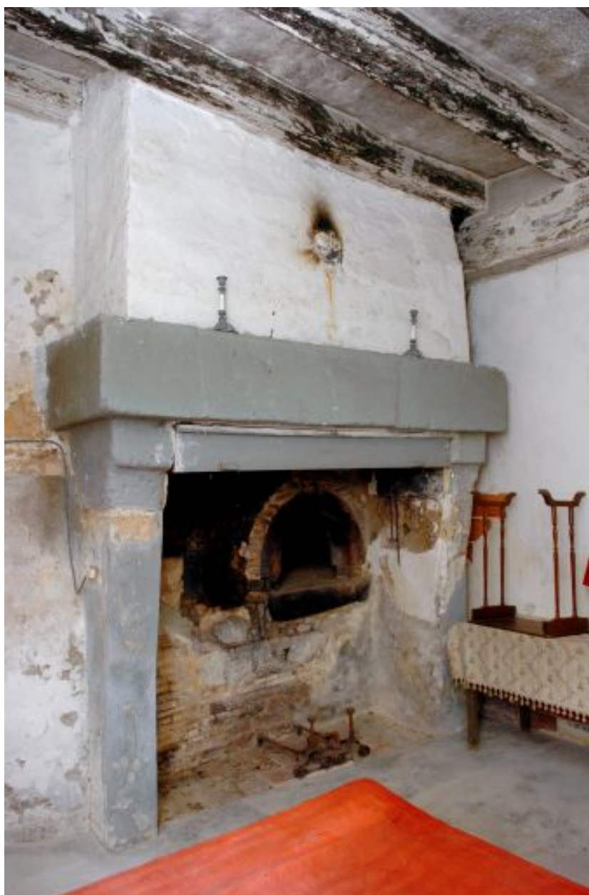
Vieille dépendance : cheminée à hotte droite.
