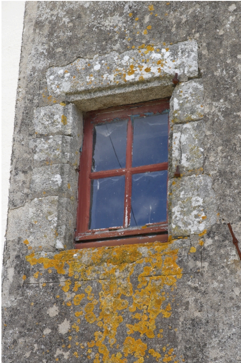
Logis. Partie est. Façade sud. Fenêtre.
