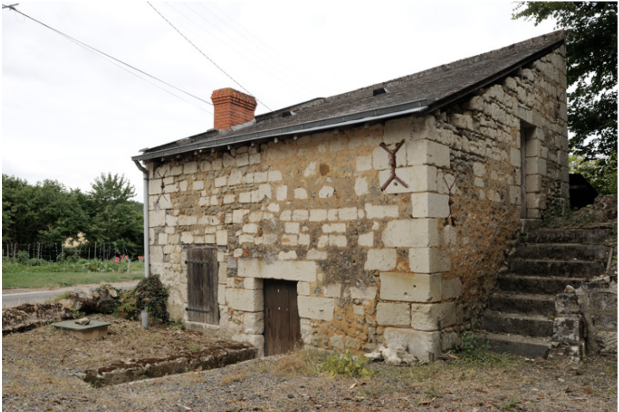
Maison et escalier d'accès au comble
