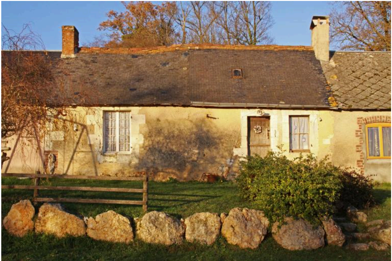
Maisons en rez-de chaussée, en écart. Le Pot Crasseux.
