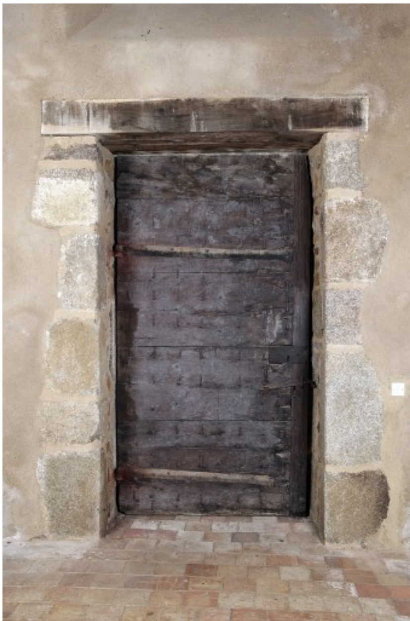
La porte vue depuis l'intérieur.
