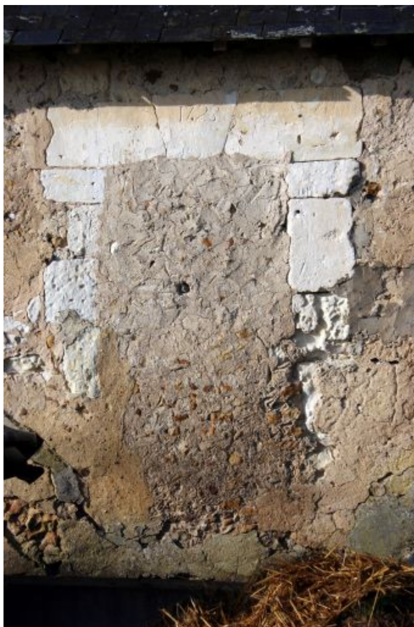
Maison 1723, façade antérieure : porte d'entrée.
