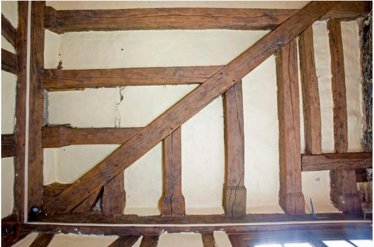
1er étage, pièce principale, angle antérieur droit : plancher du 2e étage, avec la structure de solive oblique destinée à recevoir les solives des deux élévations sur rue, vue en géométral.
