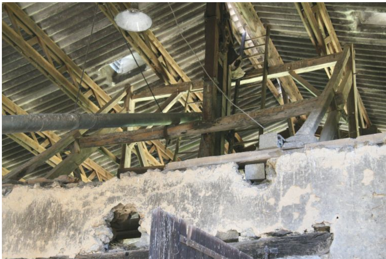
Ancienne charpente conservée sous le hangar.
