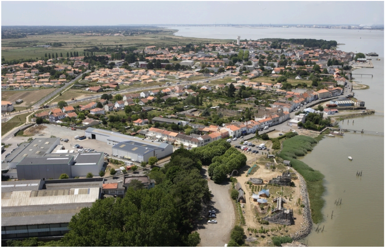
Vue aérienne de la ville depuis l'amont, 2010.
