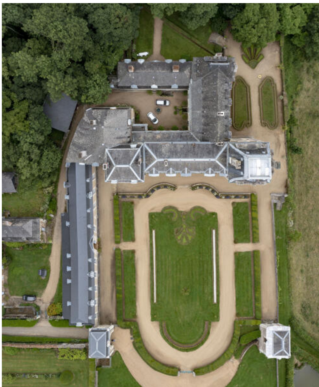
Une vue aérienne des toits du logis.
