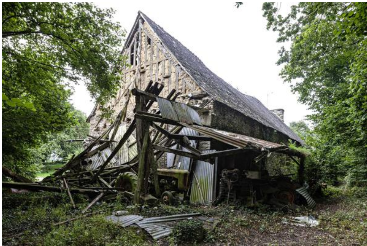
Ferme orientale, mur-pignon nord de l'étable-grange.
