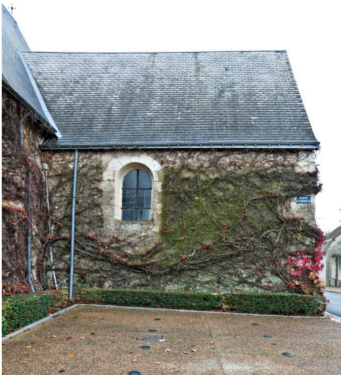
Sacristie, mur ouest.
