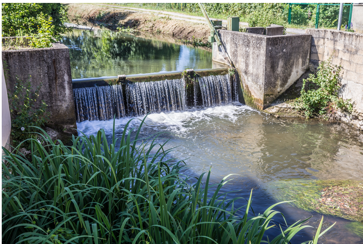
Une vanne sur le cours du Dué.
