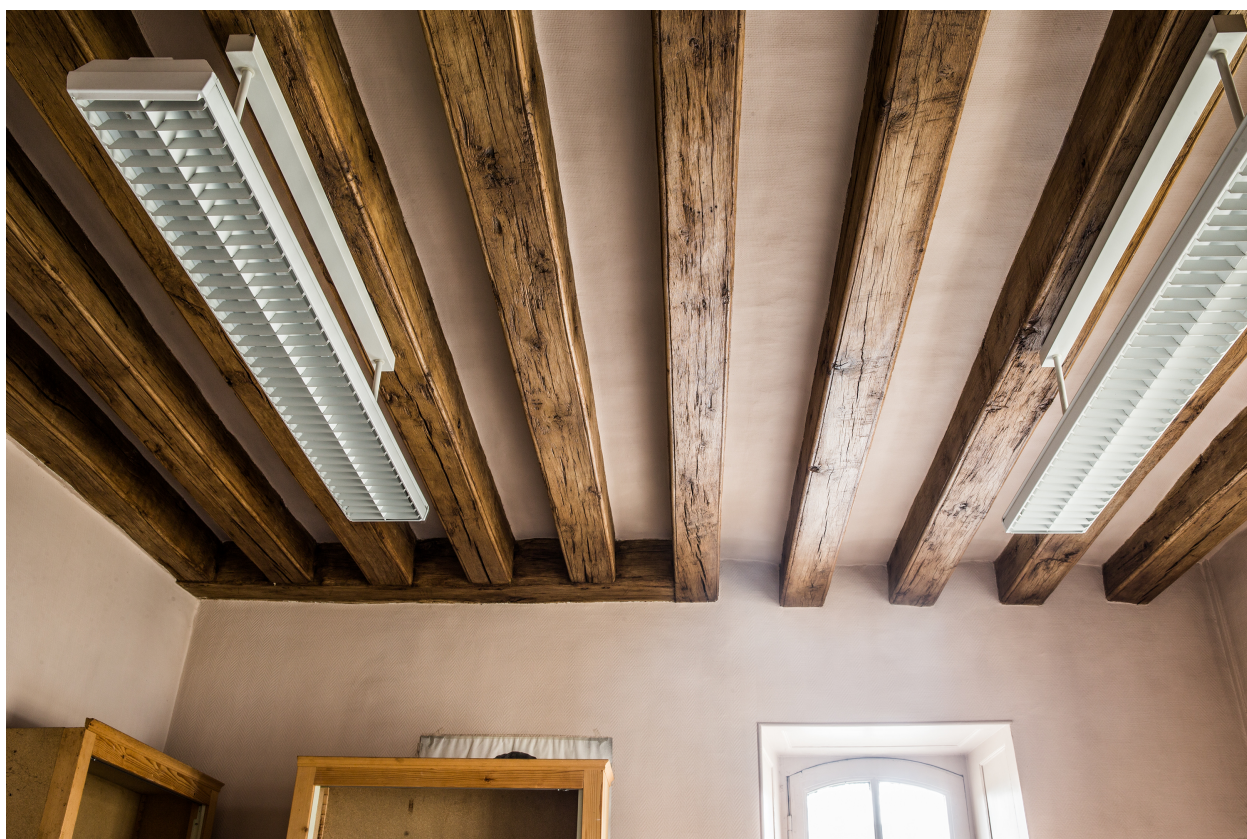
Les solives du plafond de l'étage.
