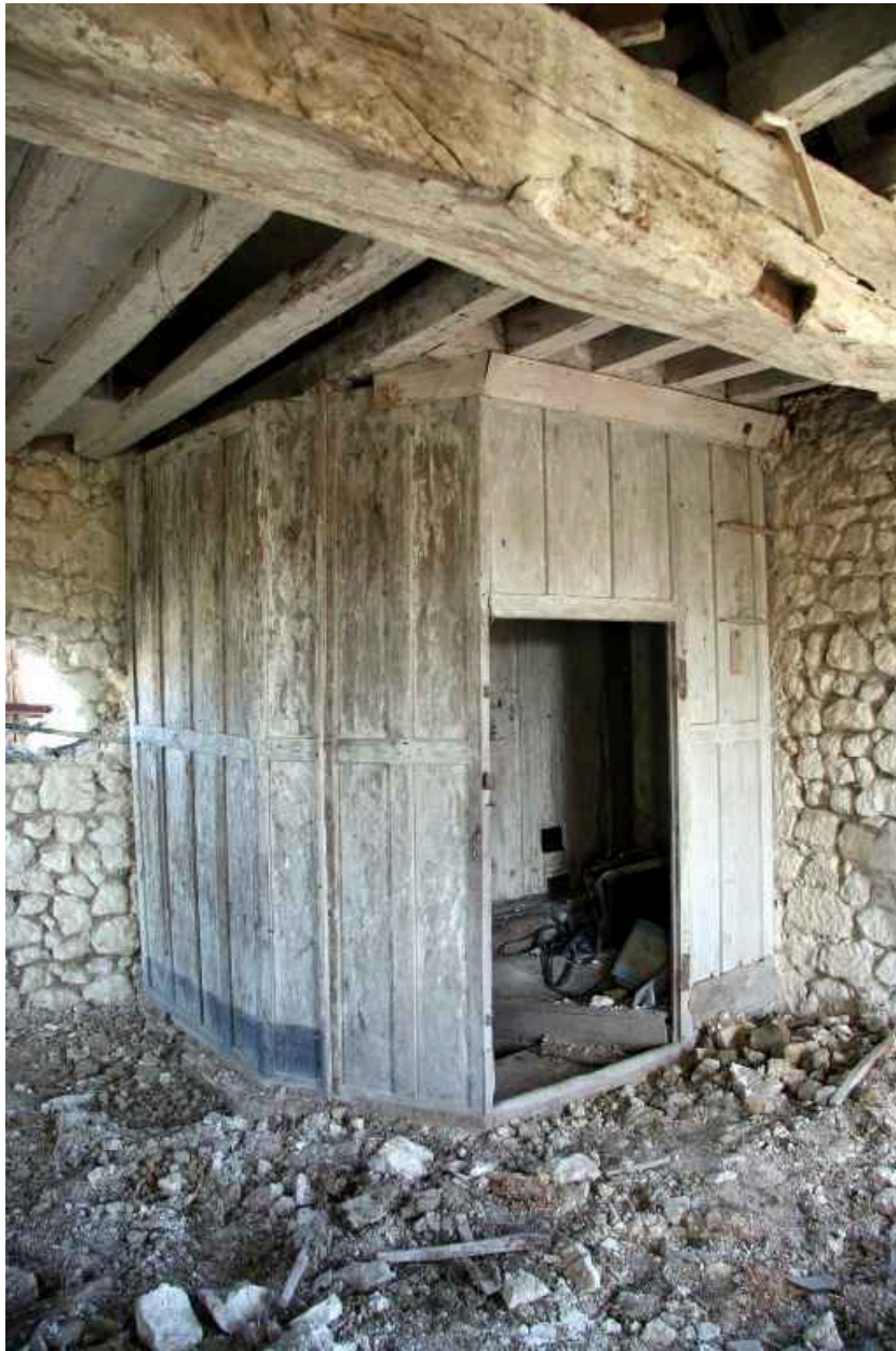
Cage d'escalier en bois : 1er étage.
