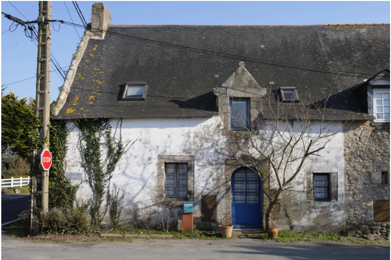
Vue du premier logis (1 rue du Vertenay).
