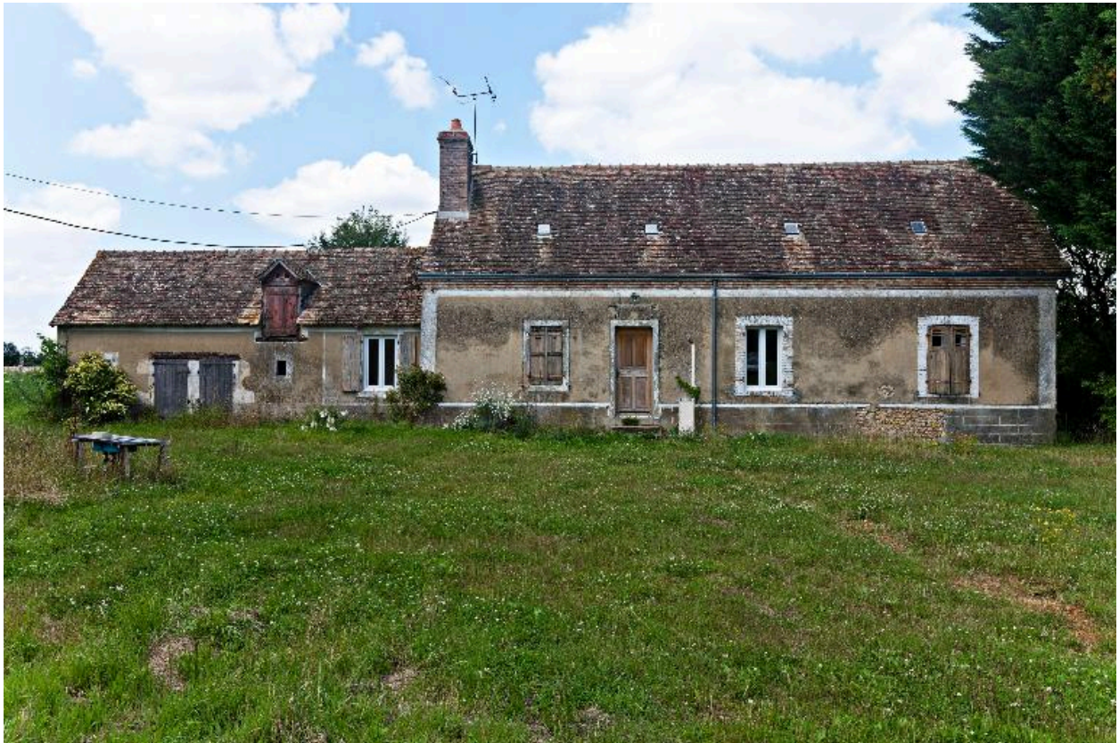
Elévations antérieure du logis et des porcheries (à gauche).
