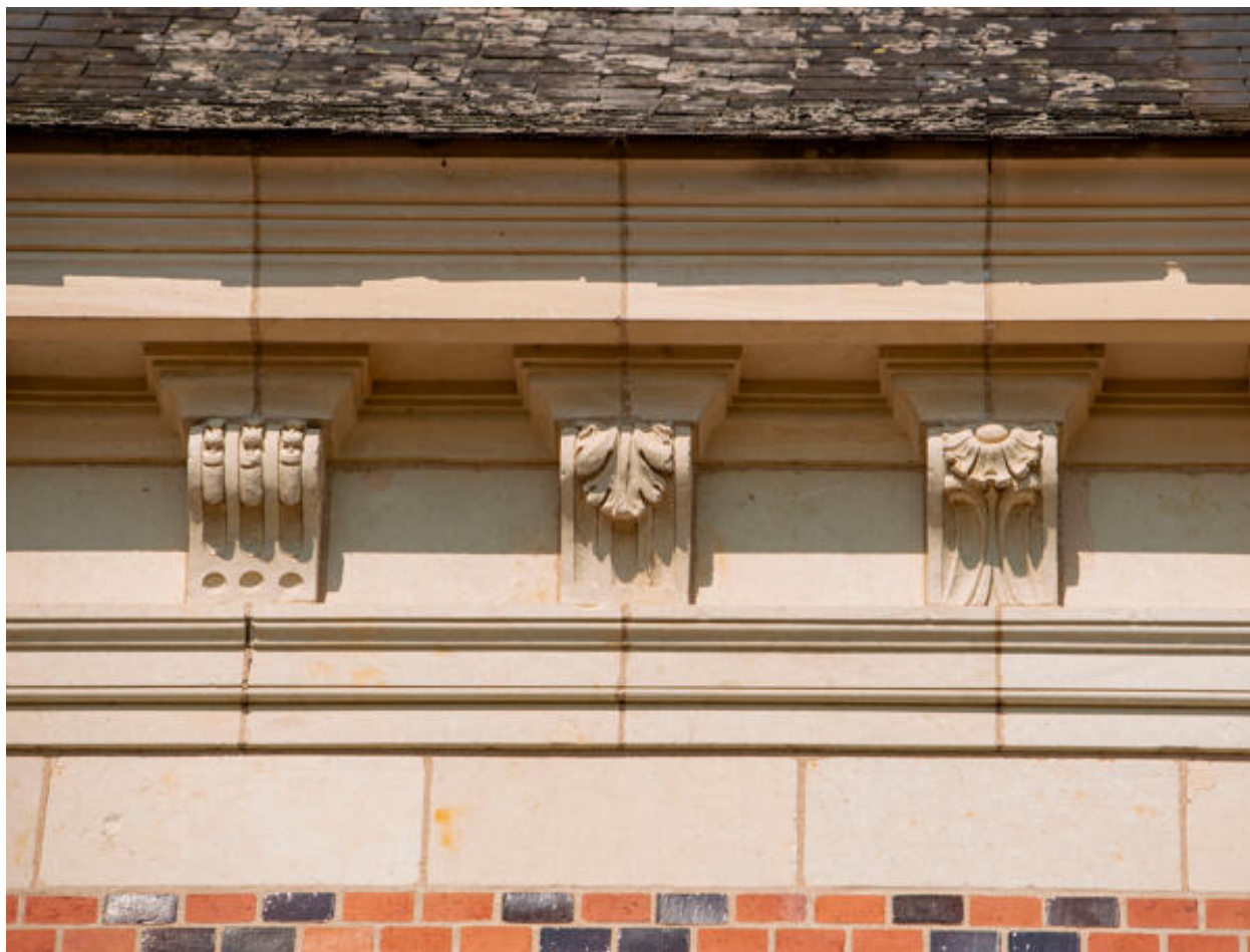
L'aile est, détail de la corniche.
