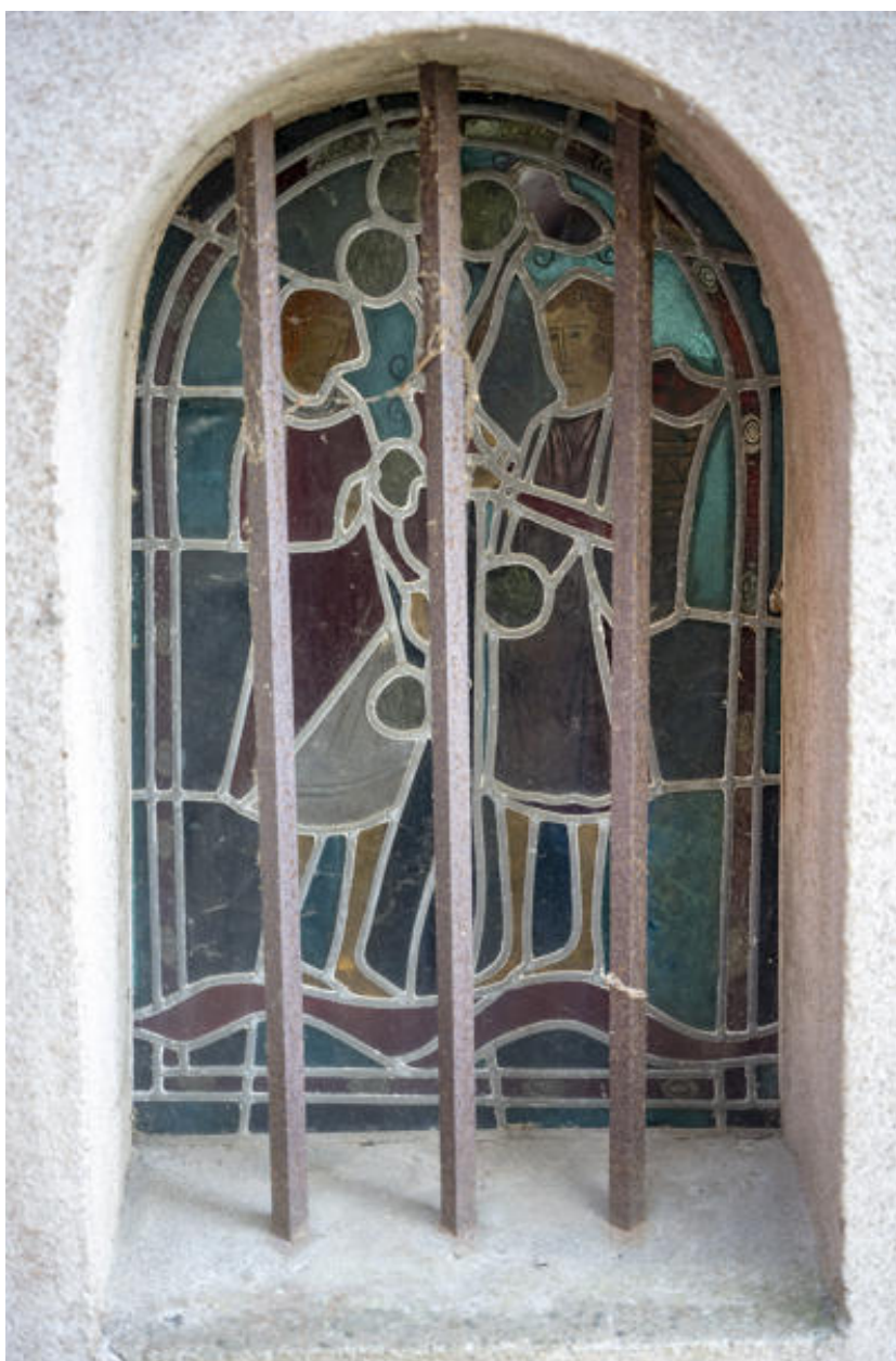
Vitrail éclairant le bâtiment de bureaux.
