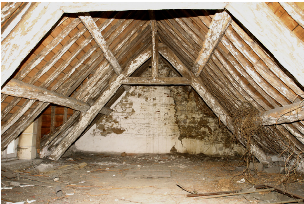
Charpente de l'aile sud, vue vers l'Ouest.
