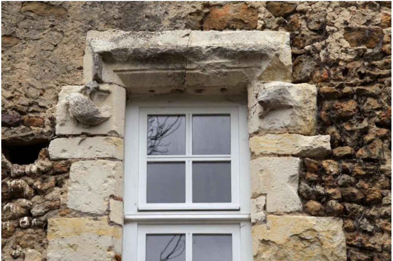
Le logis, façade postérieure : linteau de la demie baie du rez-de-chaussée.
