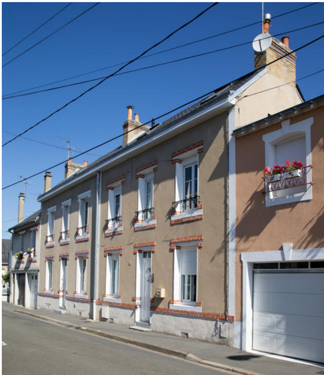
Vue d'une maison de type économique développée par Maurice Levesque rue du Creux.
