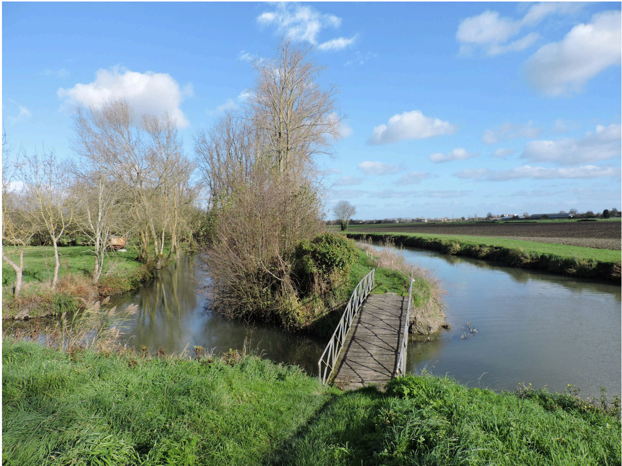
La passerelle sud-ouest entre, à gauche, la rivière de la Vieille Autise et, à droite, le canal de la Vieille Autise, vue depuis le sud-ouest.
