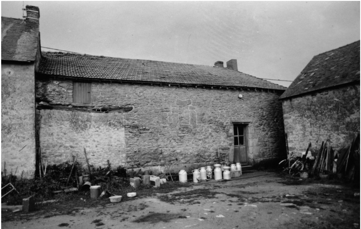
Vue des bâtiments ouest. 1990.
