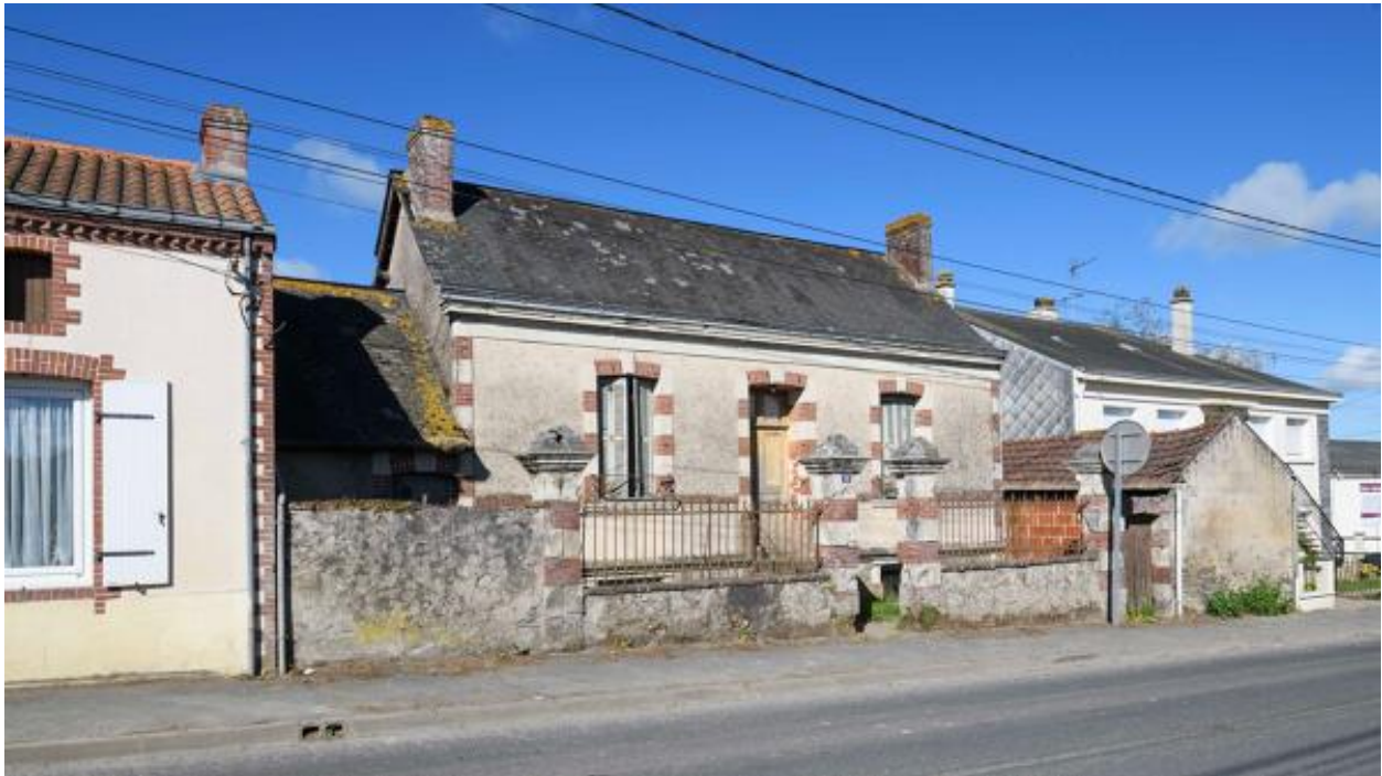
Maisons 11, 13 et 15 rue de la Loire.
