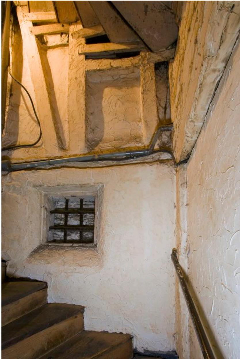
Mur arrière, angle postérieur gauche, escalier entre 1er et 2e étages : passage du mur de schiste au pan de bois, et fenêtre condamnée par la tour d'escalier en vis de la maison voisine au n° 57, rue Beaurepaire.
