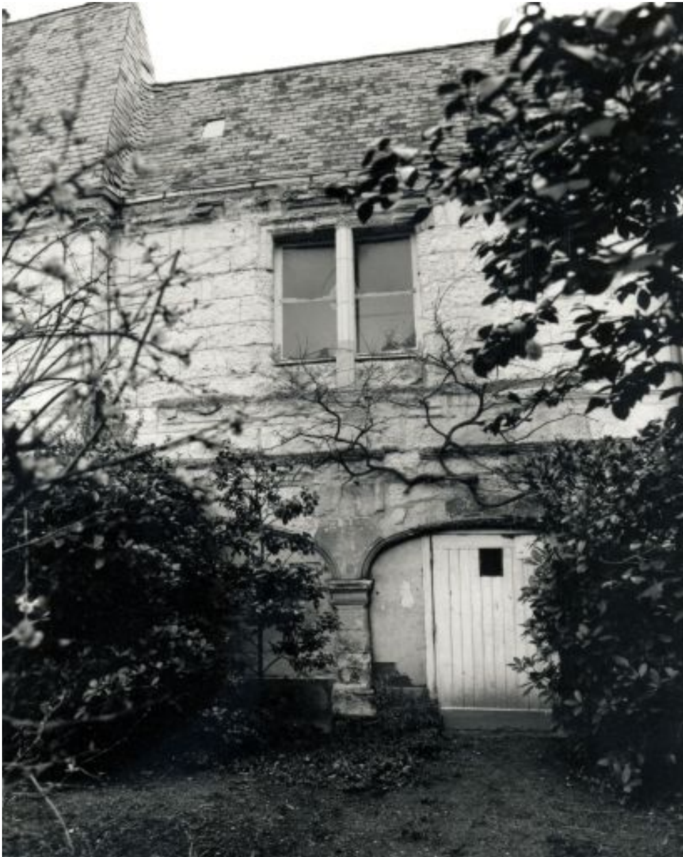
Galerie : corps secondaire, élévation sur le jardin : partie droite.
