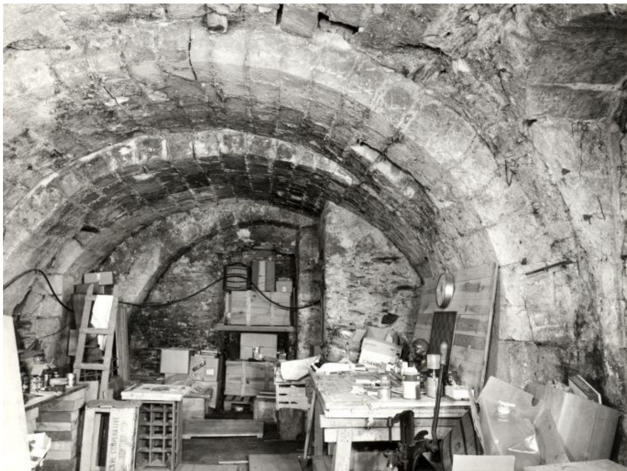
Logis postérieur, sous-sol en axe sud-ouest, nord-est.
