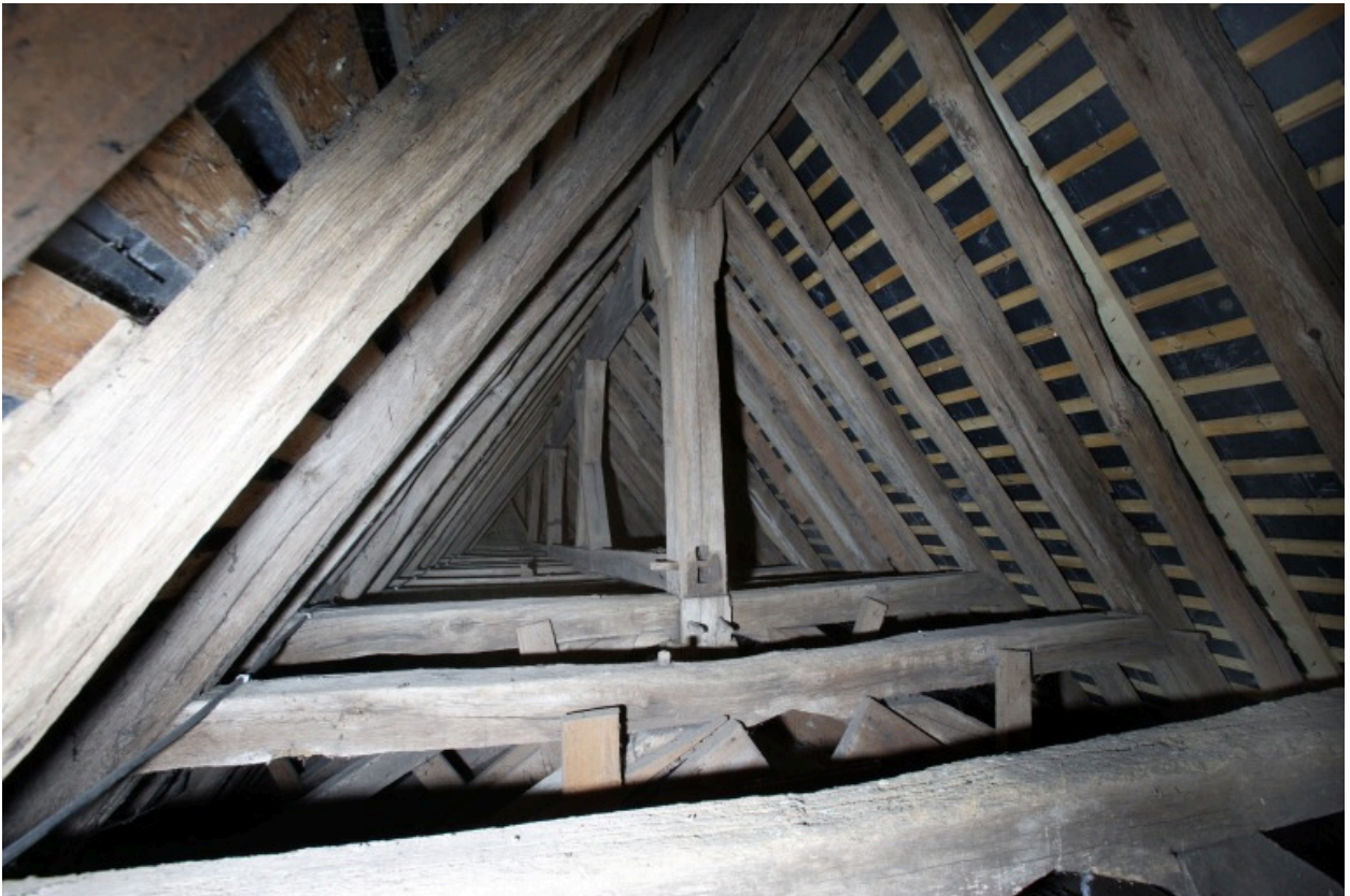
La charpente : vue d'ensemble de la charpente depuis l'ouest.
