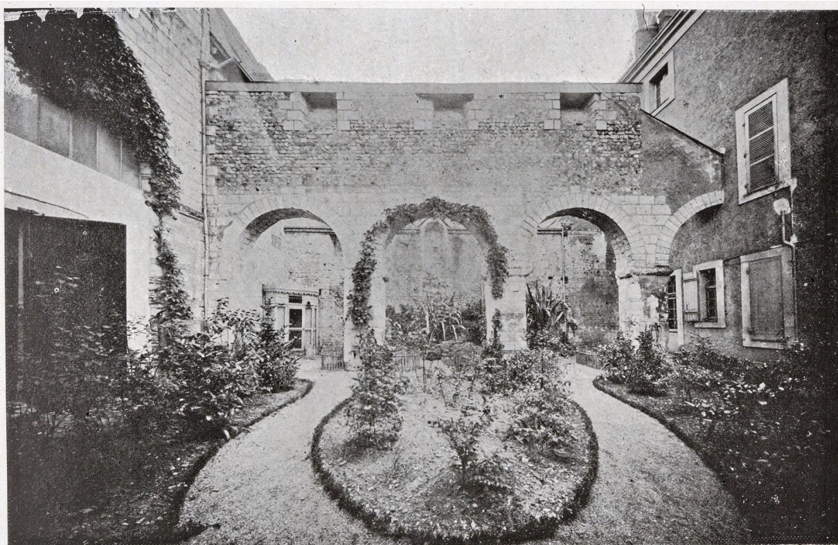
Arcades de la Basse-Nef (côté droit), de l'Eglise Saint-Martin d'Angers
