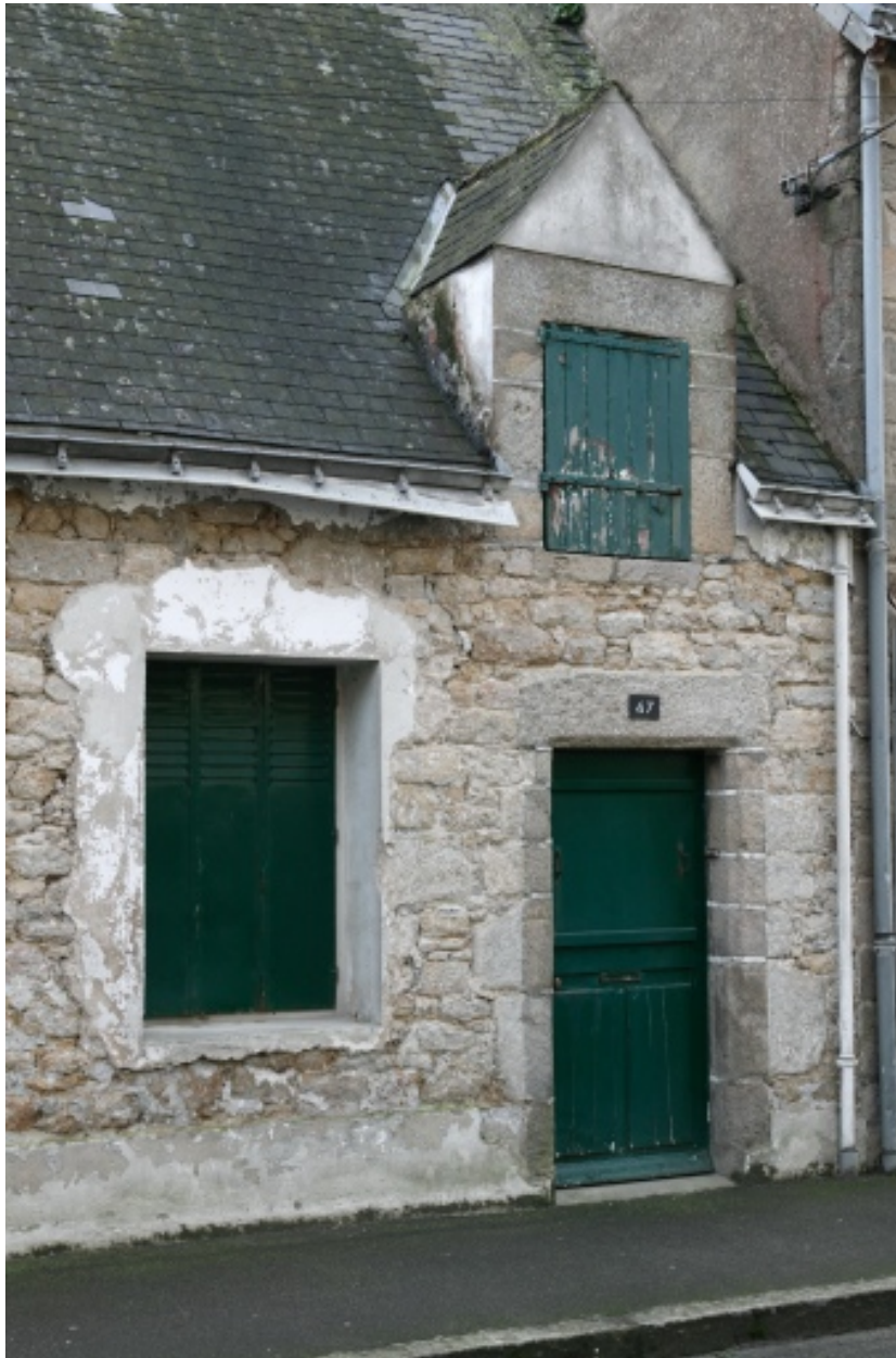
Vue de la façade sur rue.
