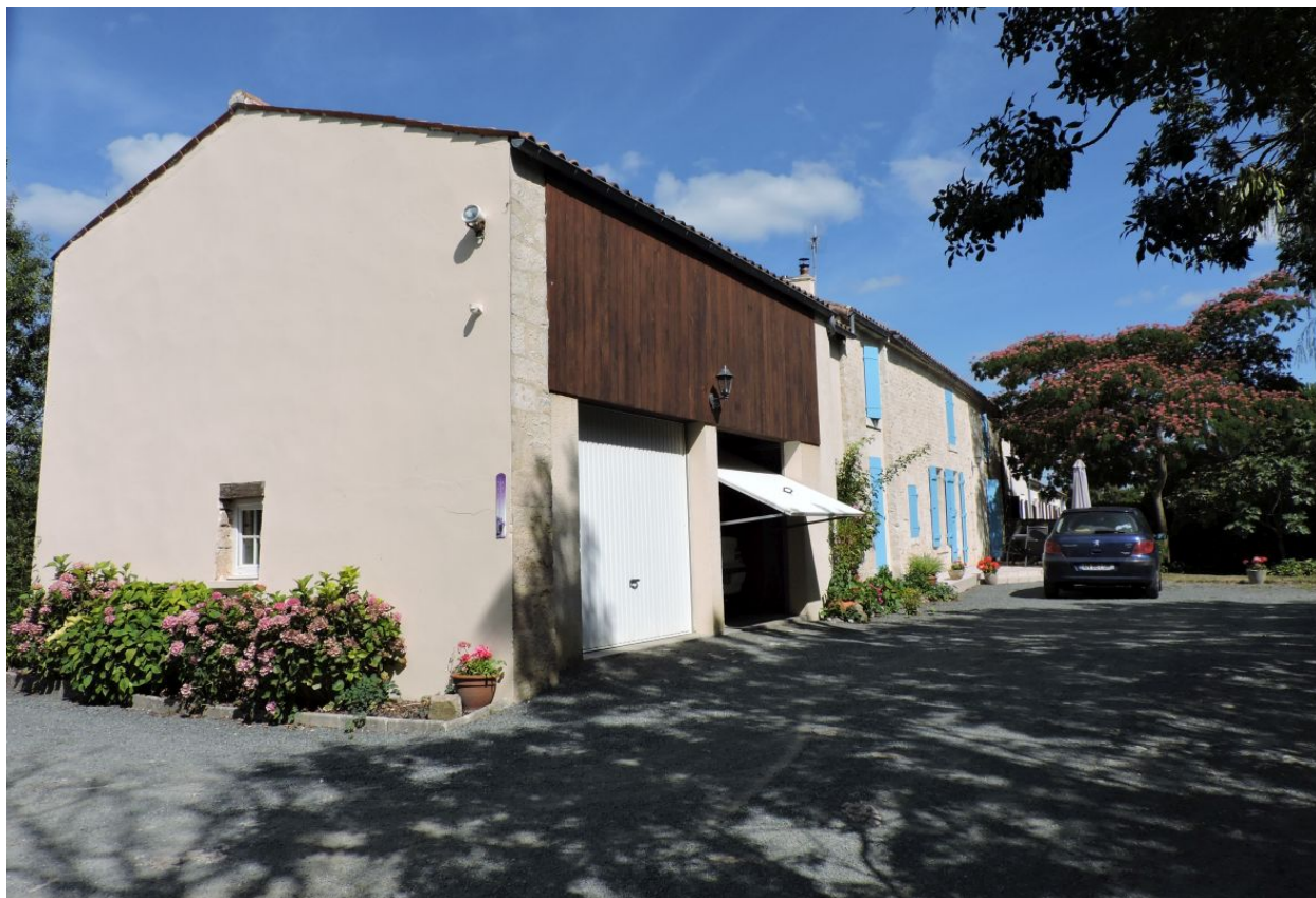
L'ancienne ferme vue depuis l'ouest.
