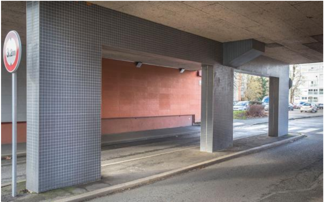
Vue du passage en rez-de-chaussée d'un immeuble rue de Belgique.
