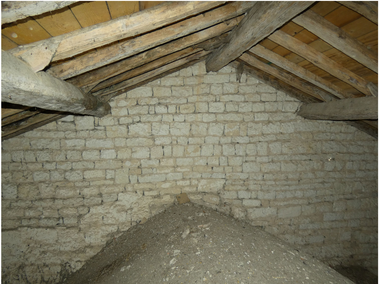
Le mur pignon ouest de l'église au niveau de la charpente.
