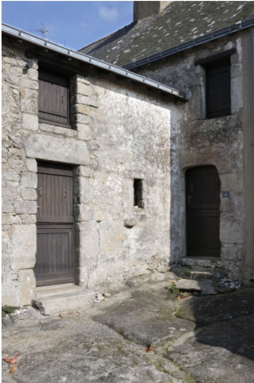
Vue du 2e logement (4 rue des Rigadeaux).
