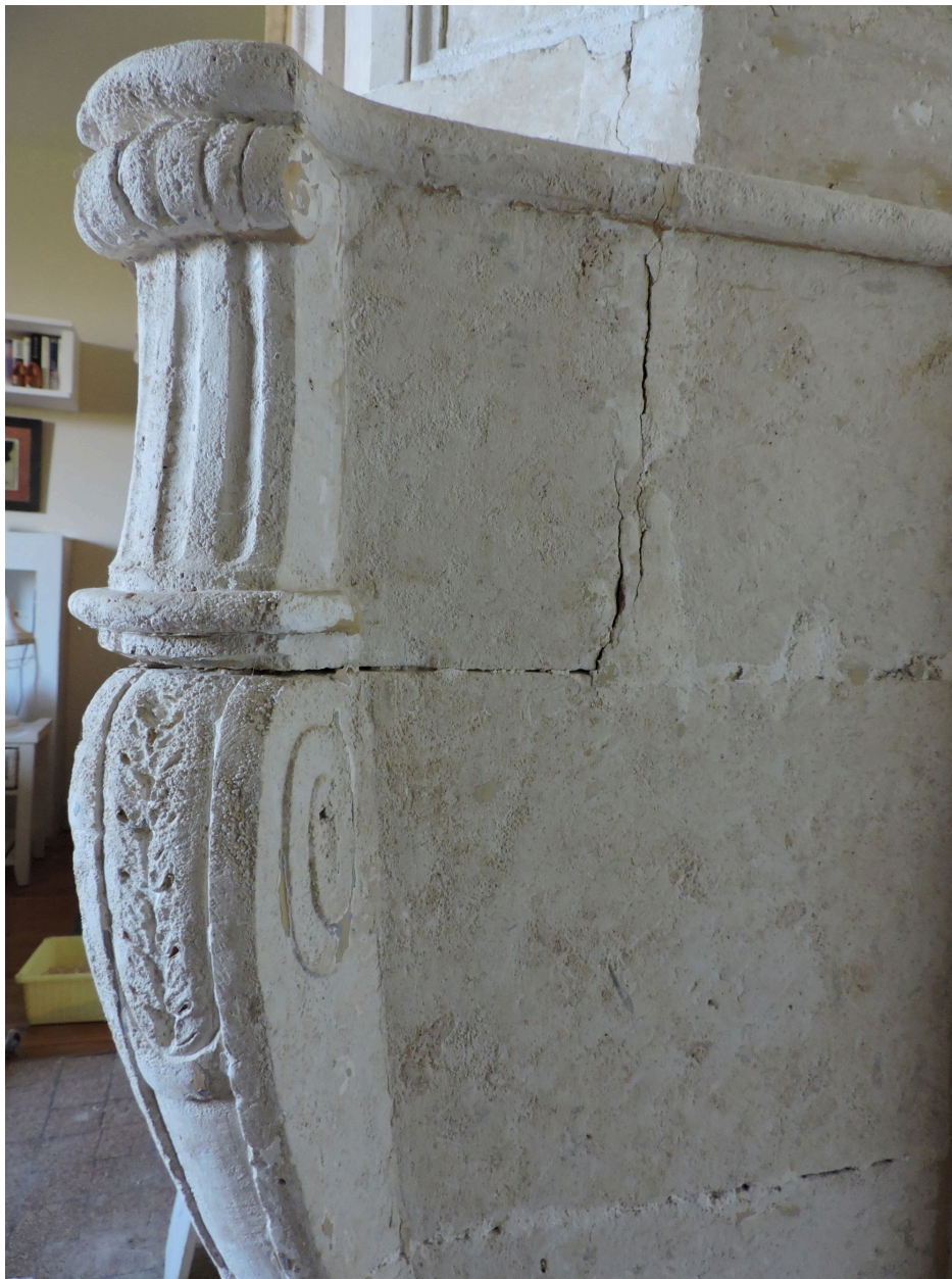
Détail du décor sculpté de la cheminée à l'étage : jambage galbé, à volutes et motifs géométriques et végétaux.
