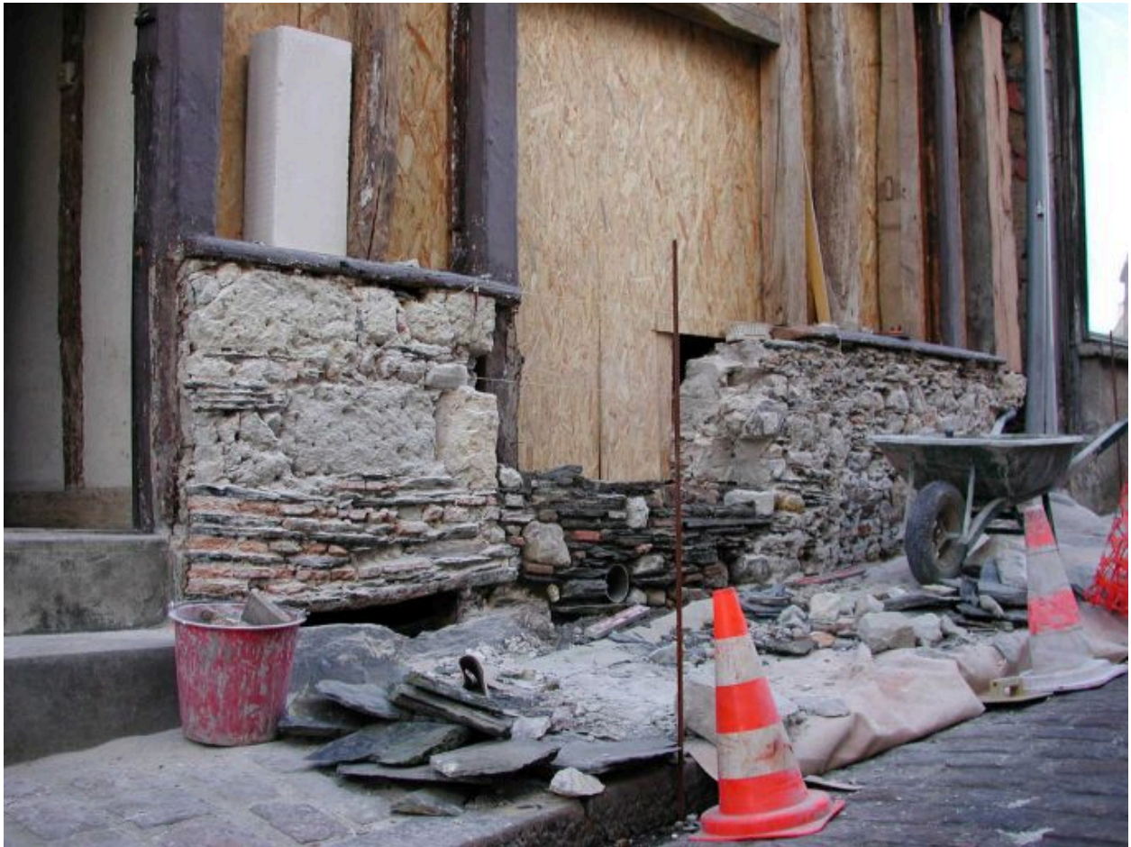
Devanture de boutique : ensemble du solin en cours de décapage, travaux oct. 2002
