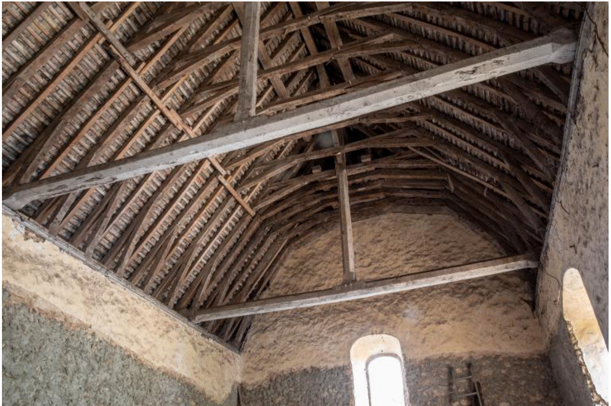
La charpente de la chapelle.
