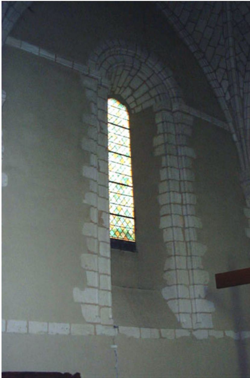
Détail d'une fenêtre dans le chœur.
