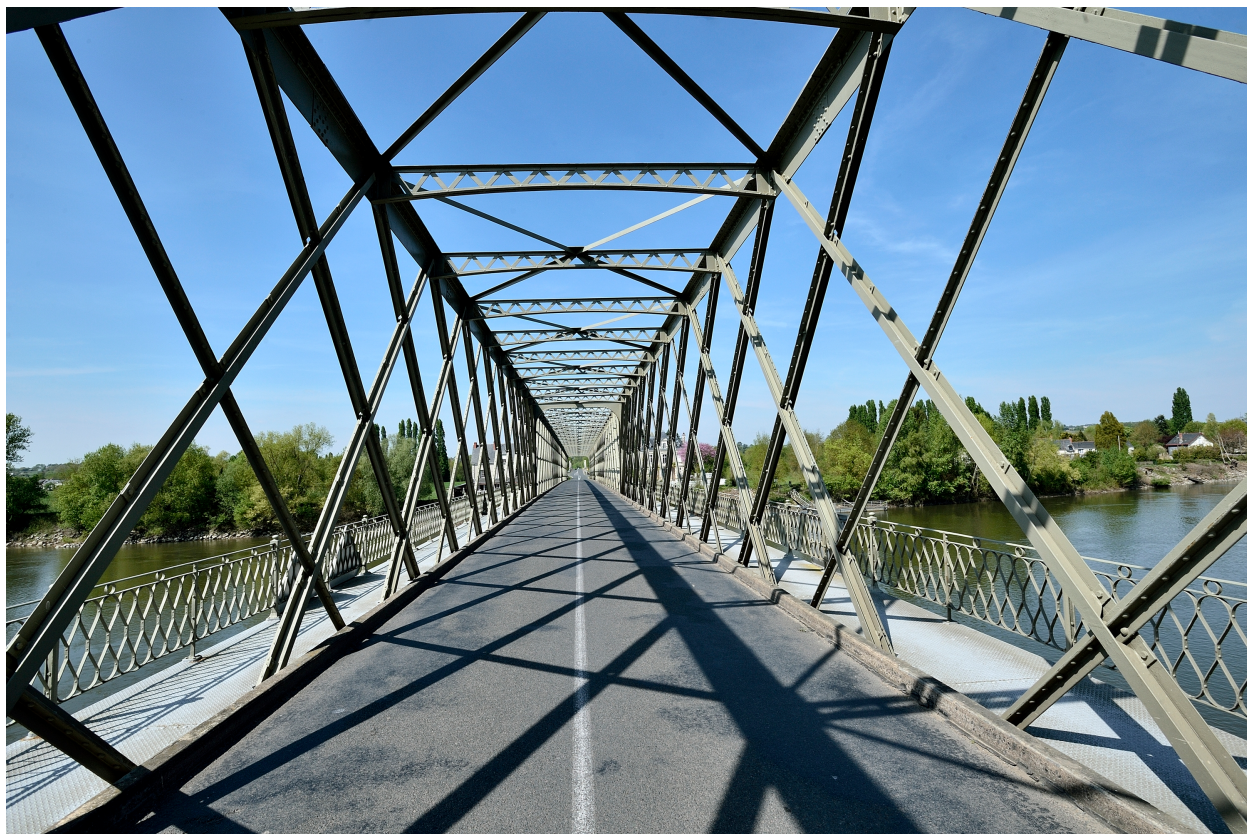
Vue vers Béhuard. Barres métalliques triangulées.
