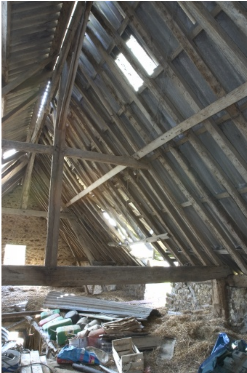
La charpente de l'étable-grange.
