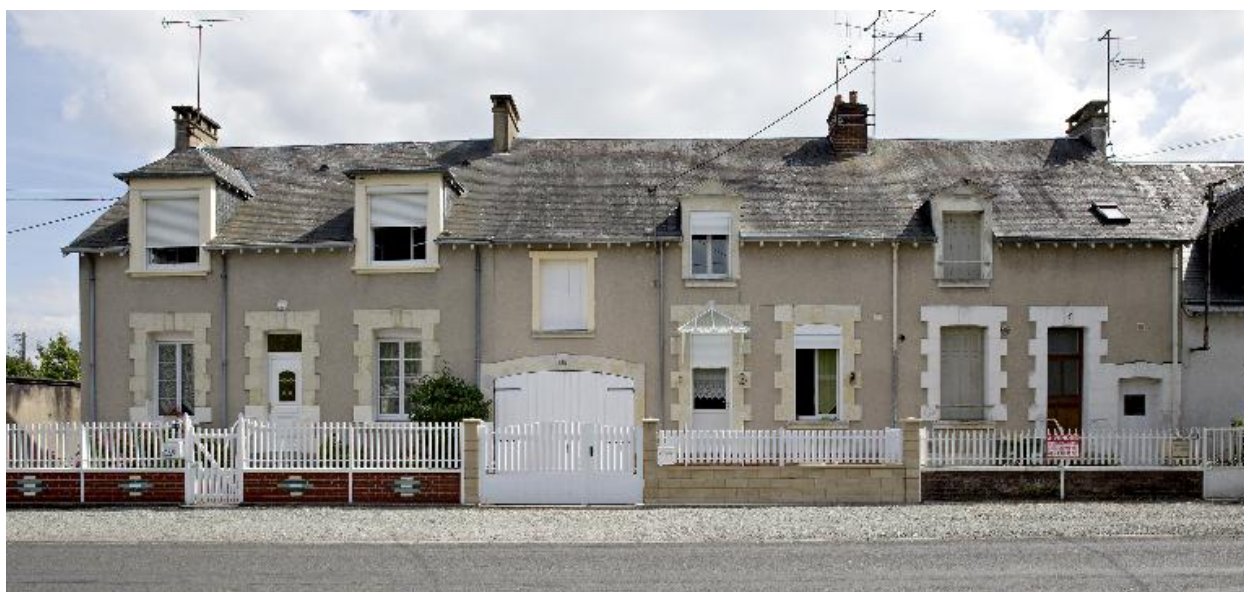
27-31, rue du Val-de-Braye. Série de maisons (3).
