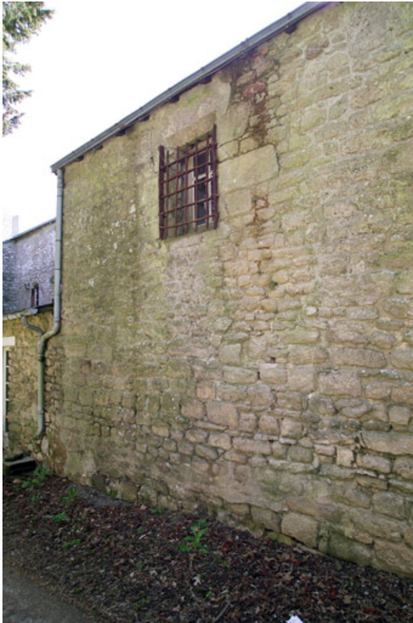
Élévation postérieure de la tour d'escalier.
