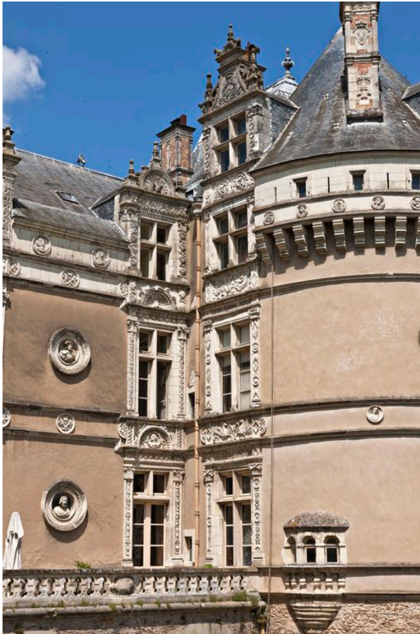
Aile sud / angle avec la tour sud-est : travées de baies dans l'angle.
