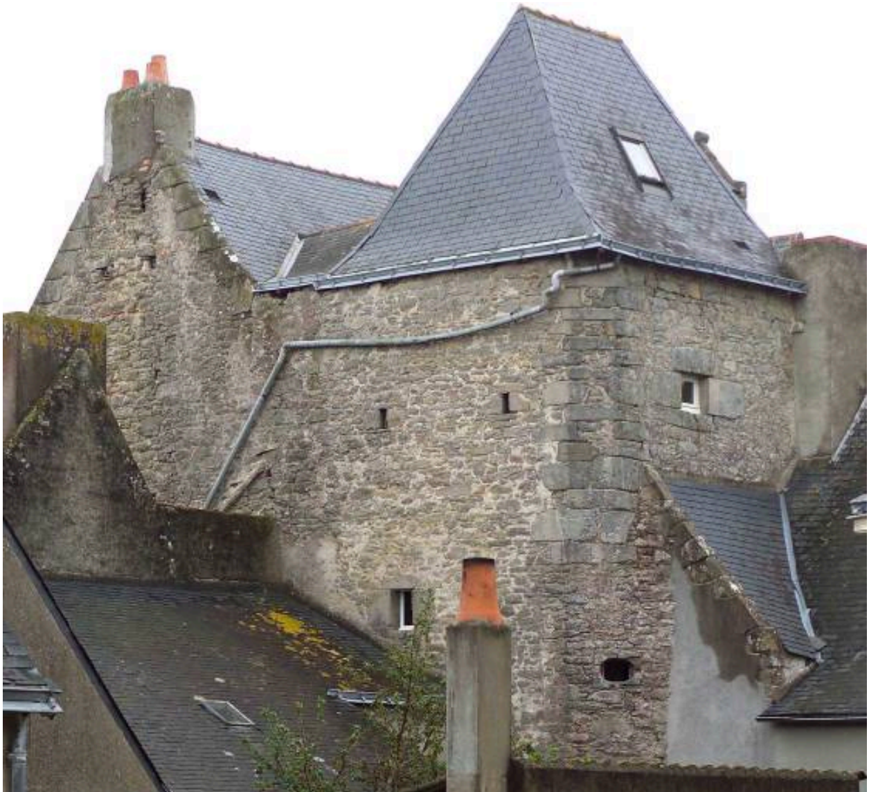
Pignon nord et tour d'escalier vus vers le Sud-Est.
