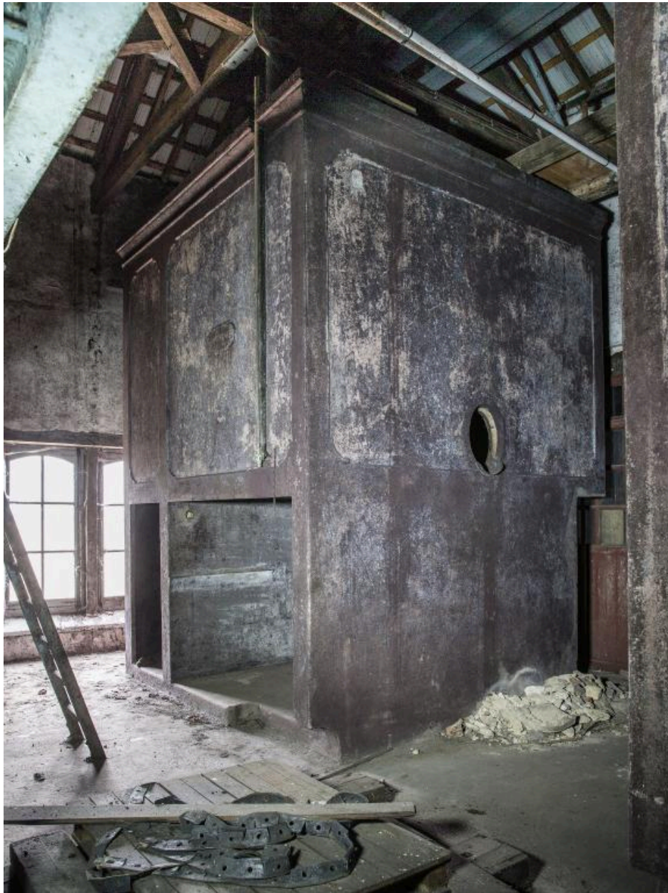
Chai sud, cuve en ciment au premier étage du pavillon, 2018.
