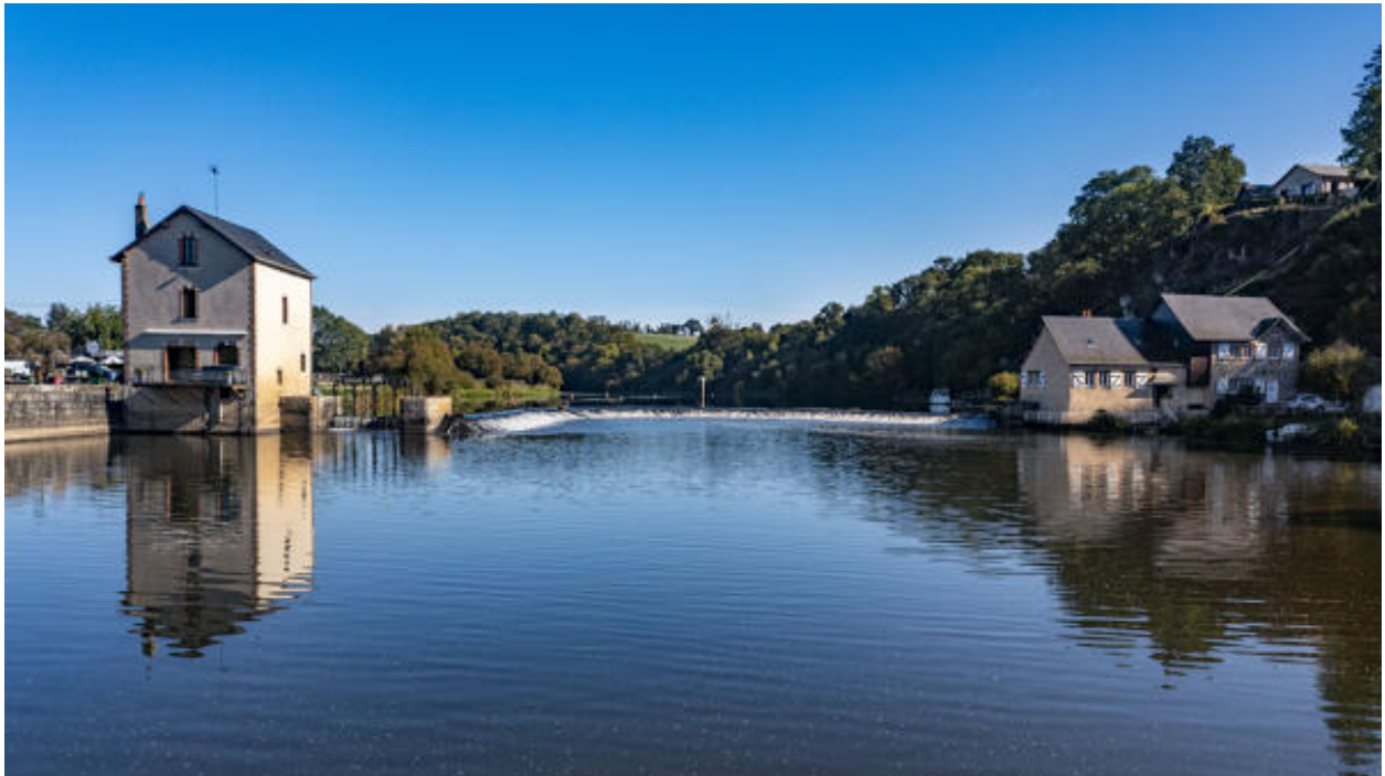
L'écluse, le barrage et les moulins.
