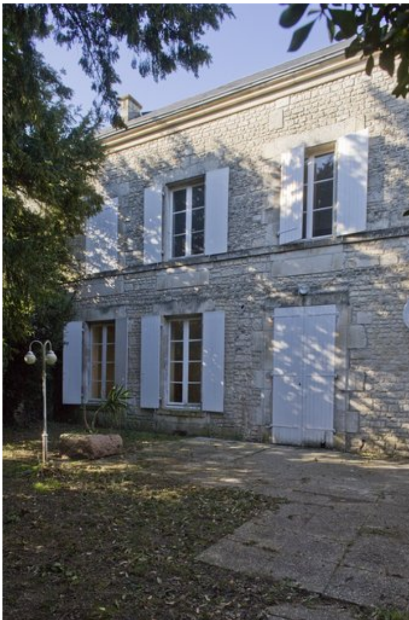
Façade sur jardin du n° 6.
