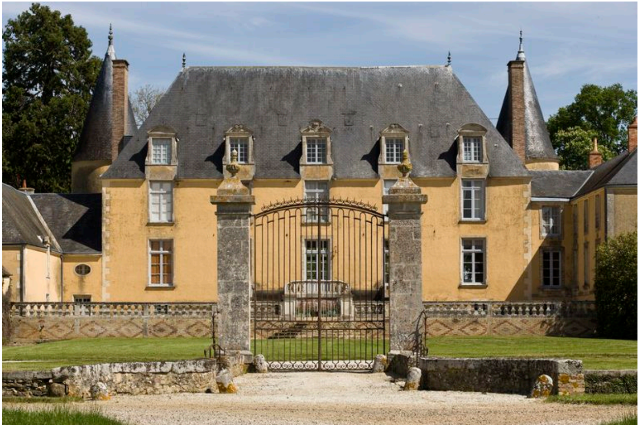
Élévation sud du logis.
